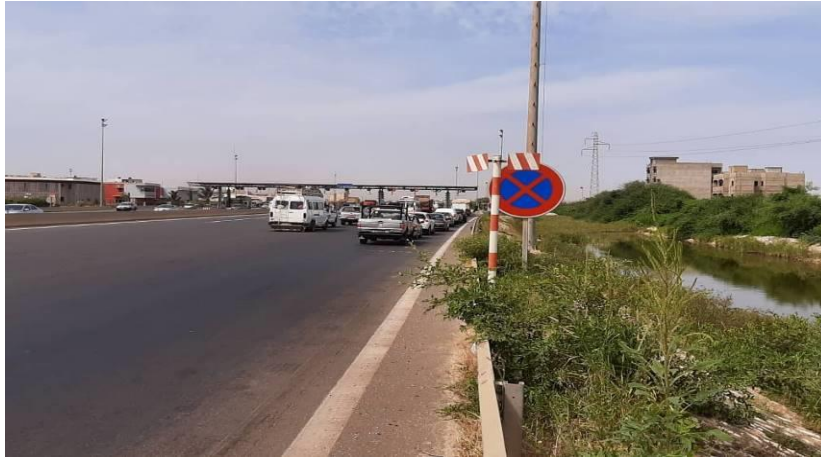
Photo 9 : Signalisation et dispositif de sécurité sur l'emprise des voies à ajouter
