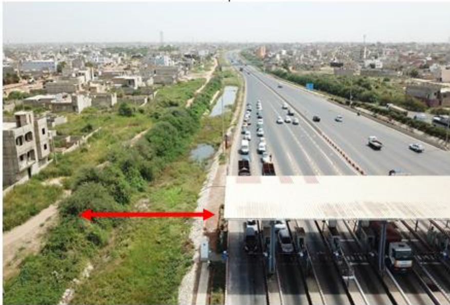
Photo 6 : Ajout de quatre voies
