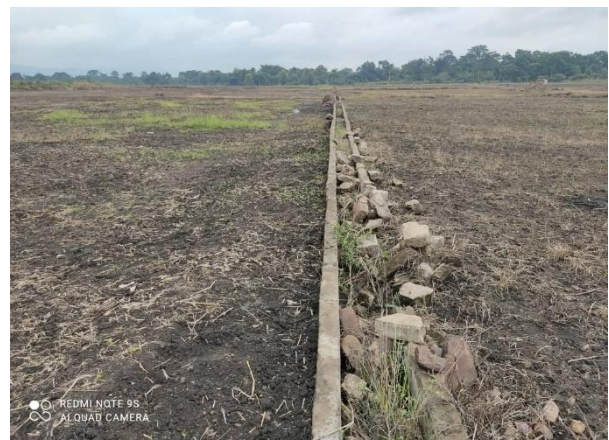
Photo 4. état d'une infrastructure de canalisation sur un site dans Kpélé 1
