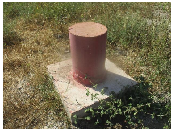
Forage F2 SDE non équipé
