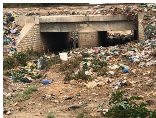
Photo 19 : Rétablissement prévu OH existant PK38-200 Photo 21 : PK 39-200 OH envahi par des ordures
