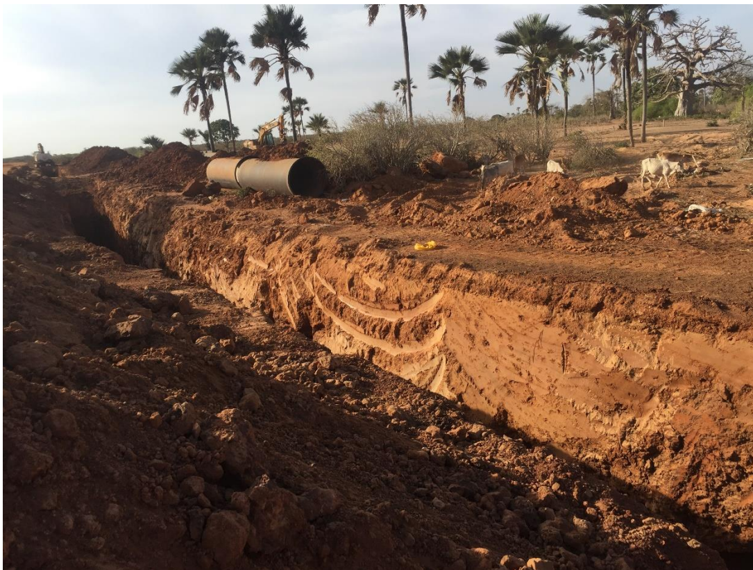
Figure 33 : Chantier pose conduite ALG3 au niveau du PK51+600
