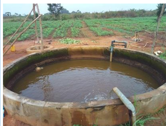
Photo 7 : Dispositif de stockage d'eau et d'irrigation
