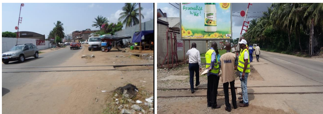
Photos 22 et 23: Croisement entre la route et le chemin de fer sur la rue Thomas Edison (Source, BNETD, 2018)
