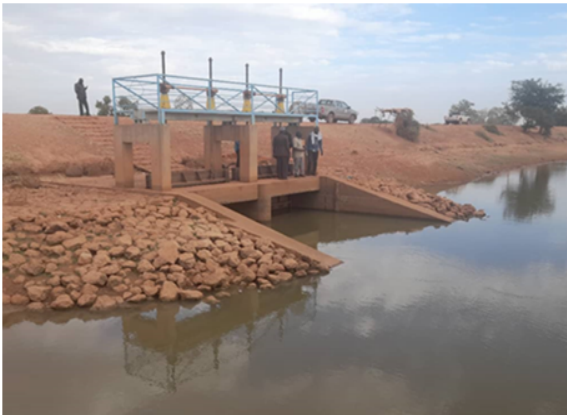
Photo 2 : Vue sur l'ouvrage de prise de la plaine de woloni
