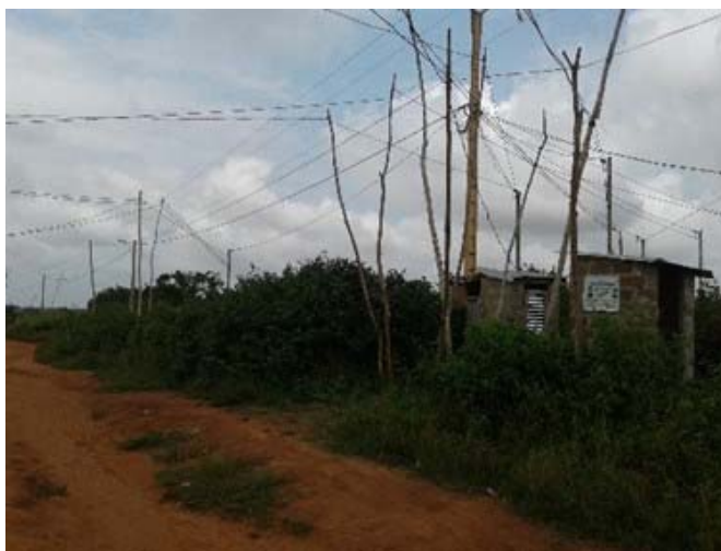
Photo 18 : Postes Compteurs SBEE dans l'emprise de la ceinture 3
