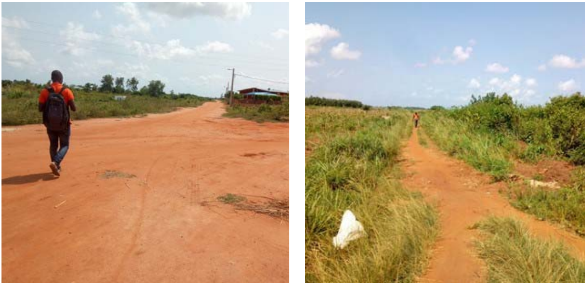
Photo 20: Vue d'ensemble de la ceinture 4
