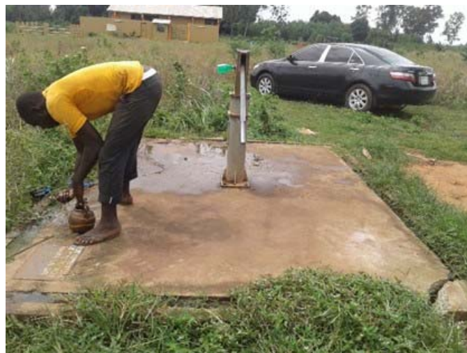
Photo 5 : Adduction d'Eau Potable réalisée dans le marché de bétail
