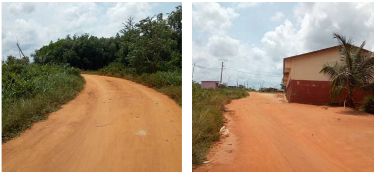
Photo 16 : Vue d'ensemble de la ceinture 3
