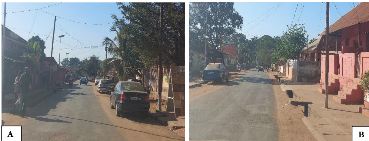
Photos 3: Vues partielles du tronçon de la Rue 2 èm Equadra/Grandja (A) et (B)/Janvier 2023.
