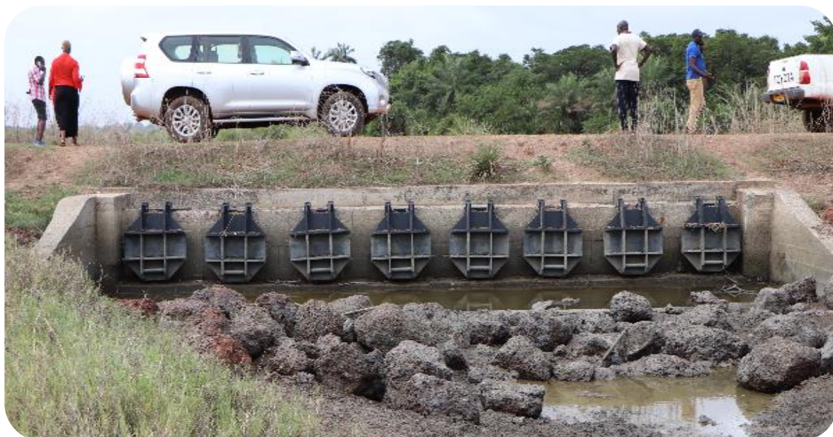
Déversoir de Cuduco, Tombali
