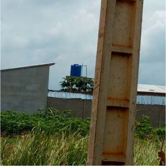
Photo 4 : Poteau électrique dans l'emprise de la ceinture 1
