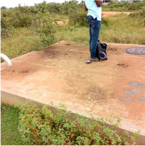
Photo 3 : Regard de la SONEB dans l'emprise de l'axe central
