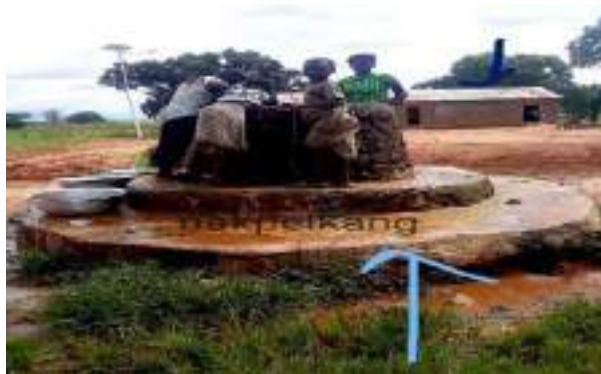
Photo 171 : Puits à Nakpelkang
