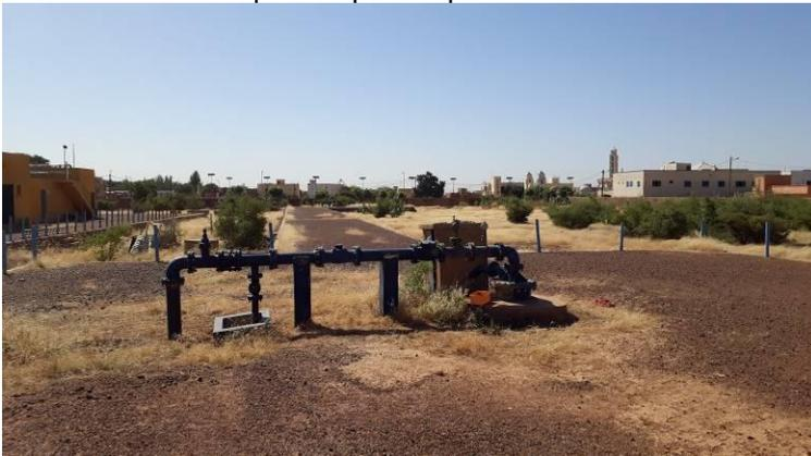
**Photo 7** : bloc captage (forage F1 et F2)
