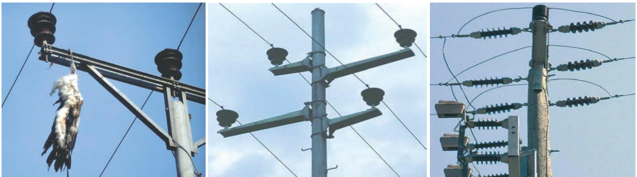
Planche 6 : Mats dangereux pour les oiseaux (Photos : A. Aebischer et CFF en 2022)
