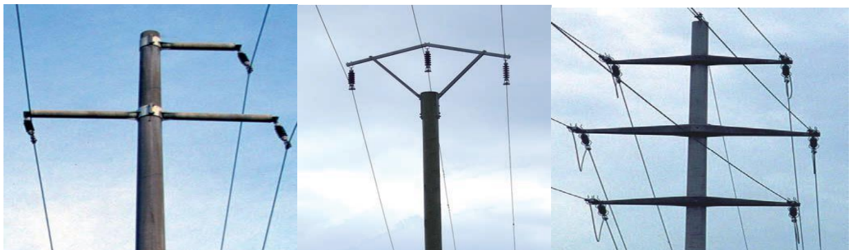
Planche 7: Mâts sûrs pour les oiseaux (Photos: A. Aebischer et CFF)
