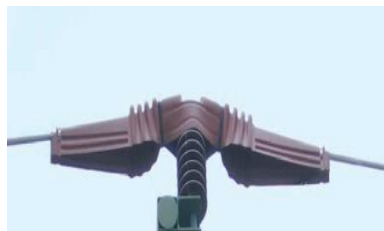
Photo 8 : Isolateurs dressés avec calottes de recouvrement sur une longueur d'au moins 60 cm. (Photo: A. Aebischer 2022)
