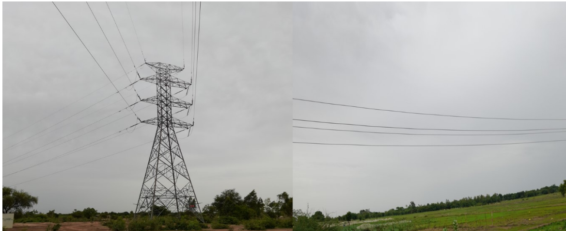
Figure 7: Ligne de haute tension traversant la voie de contournement et la plaine rizicole
