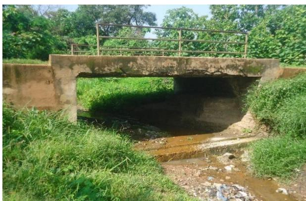
**Photos 26** : PK 9+920 – pont cadre 1x5,00x2,00 vétuste à démolir et remplacer par un nouvel ouvrage à dimensionner
