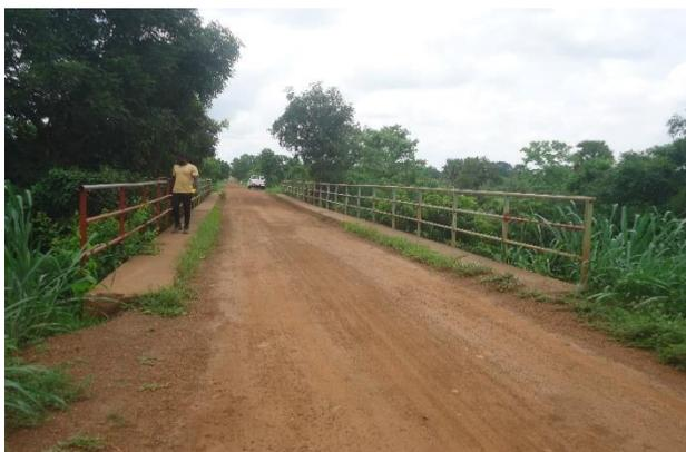
**Photos 27** : PK 26+500 - Pont à poutres à une seule travée de 22 m sur la rivière Bongolo avec 3,60 m de largeur roulable en bon état à conserver et dédoubler
