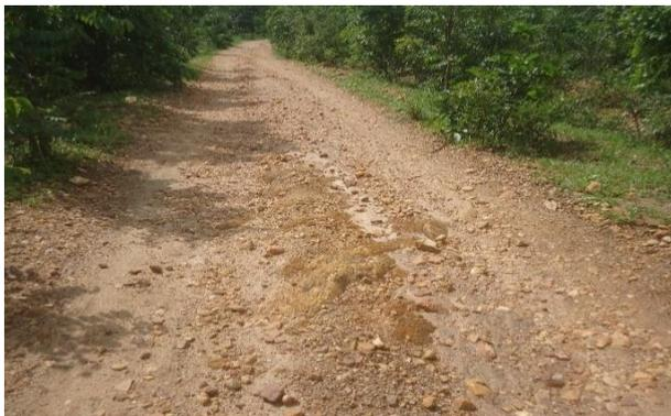
**Photos 10** : PK 2+000 – sol de plateforme constitué de gravier roulé
