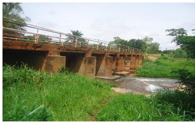
**Photos 15** : PK 7+280-7 pont dalle à 10 travées de 3 m à démolir et remplacer par un nouvel ouvrage à dimensionner
