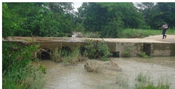
**Photos 24** : PK 5+740 – Radier busé à démolir et remplacer par un nouvel ouvrage à dimensionner
