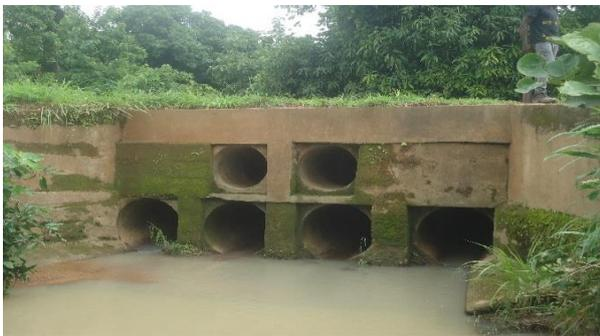
**Photos 18** : PK 12+860 6 buses Ø800 à démolir et remplacer par un nouvel ouvrage à dimensionner
