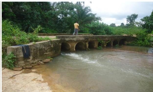
**Photos 11** : PK 3+130 – 7 buses Ø800 existants à démolir et remplacer par un nouvel ouvrage à dimensionner
