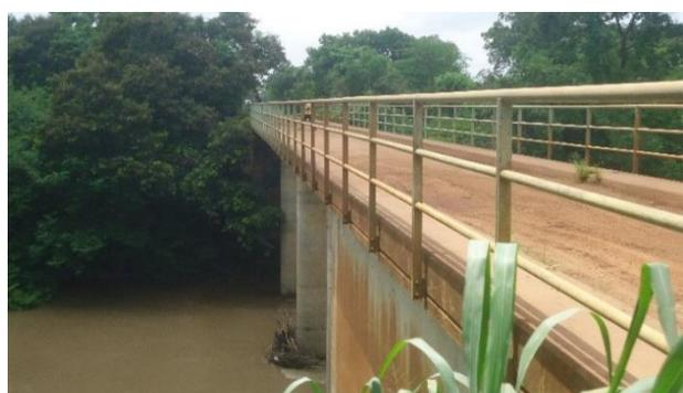
**Photos 28** : PK 27+050 - Pont à poutres à 4 travées de 15 m sur la rivière Mono avec 3,60 m de largeur roulable en bon état à conserver et dédoubler
