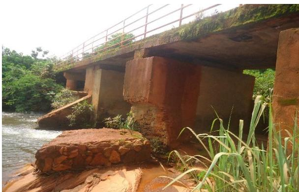
**Photos 14** : PK 3+500 – pont dalle à 5 travées de 5 m sur la rivière Sara à démolir et remplacer par de nouvel ouvrage à dimensionner
