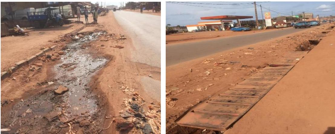
Photo 4 : Caniveaux obstrués par toutes sortes de dépôts solides
