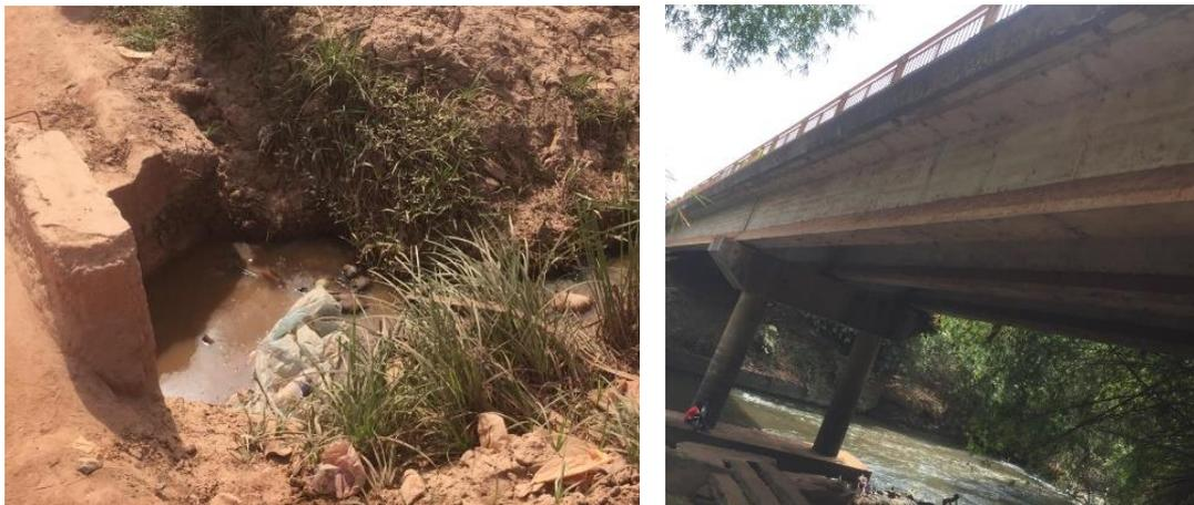
Photo 6 : Ponts à poutre sous-chaussée et buses endommagées sur la route San Pedro – Grand Béréby
