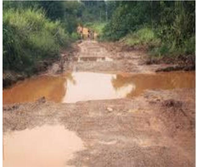
Photo 1 : Vues du niveau de dégradation avancée de l'itinéraire Fresco - Sassandra
