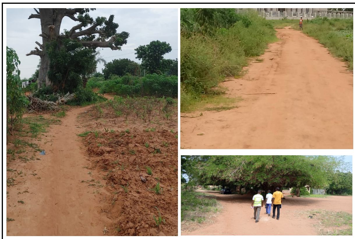
Figure 19: Etat des lieux de la voirie et de la localité de Bè-Kléné
