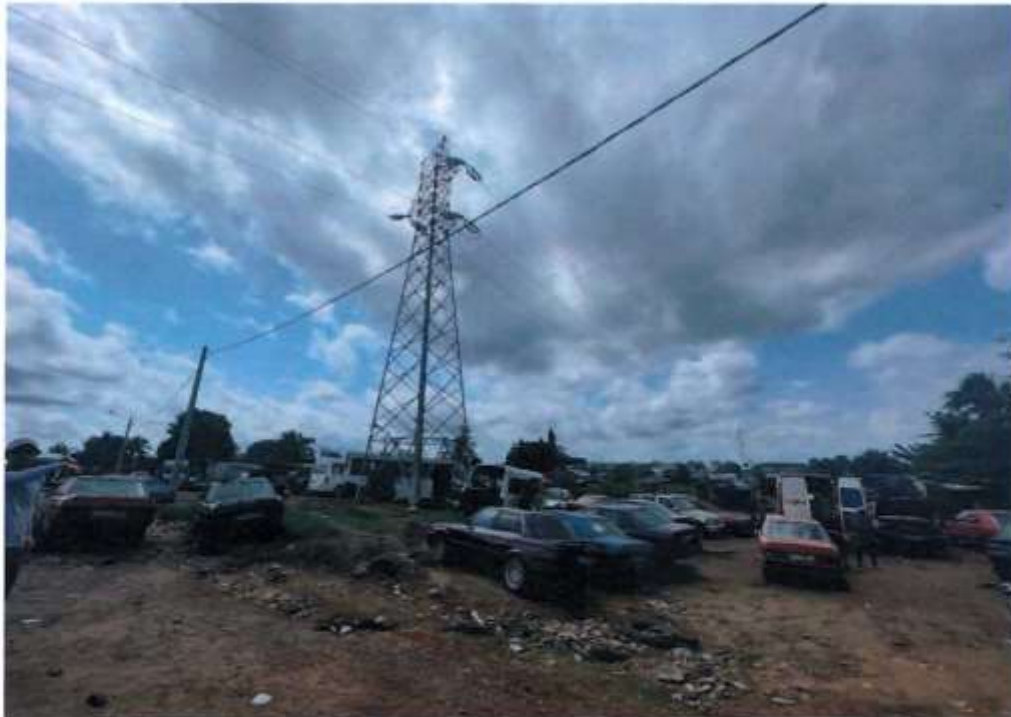
Figure 2-6 Lignes de transmission et pylônes existants à partir du poste 90 kV de Dabou
