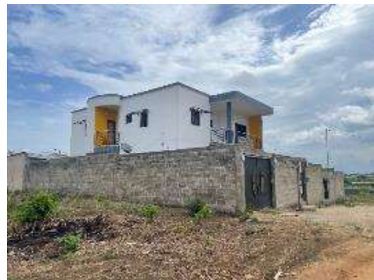
Maison d'habitation à Dabou qui tombe dans l'emprise, entre les pylônes 16 et 17 (photo ERM prise le 25 mai 2023)
