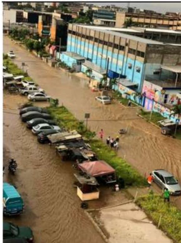
Figure 4-29 Inondations à Abidjan en 2021
