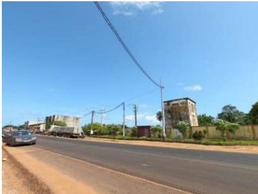
Figure 2-8 Poste 90 kV de Dabou
