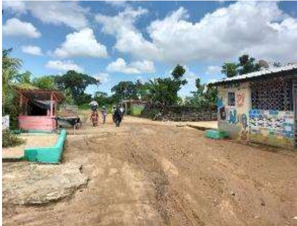
Route non asphaltée à Songon-Dagbé (photo ERM prise le 23 mai 2023)
