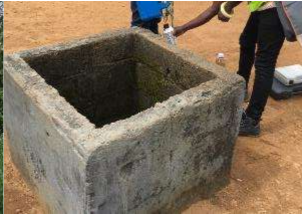
Puits d'eau dans le village de Songon Dagbé
