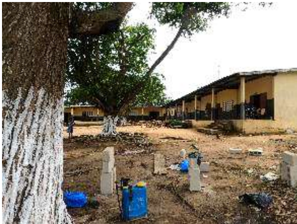
Ecole primaire et secondaire Les Palmier à Dabou (photo ERM prise le 18 septembre 2023)
