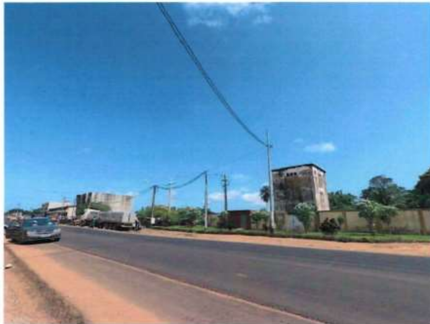
Figure 2-4 Poste 90 kV de Dabou
