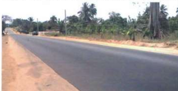
Figure 4-22 Vue de la route côtière Yopougon Dabou
