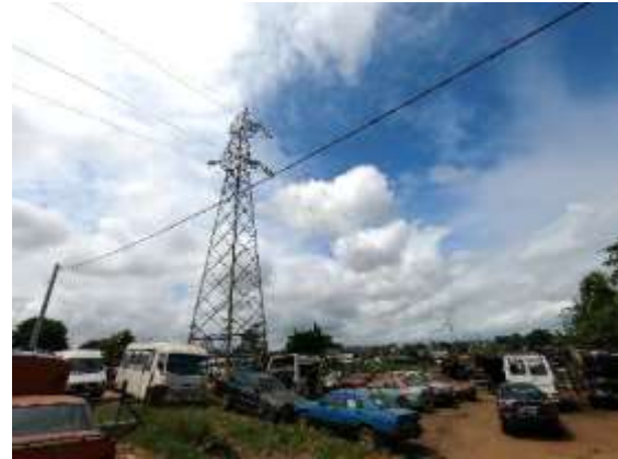
(F) Pylônes de lignes existants près de la sous-station de Dabou et un garage qui tomberont dans l'emprise de la ligne souterraine 225 kV (photo ERM prise le 18 septembre 2023).
