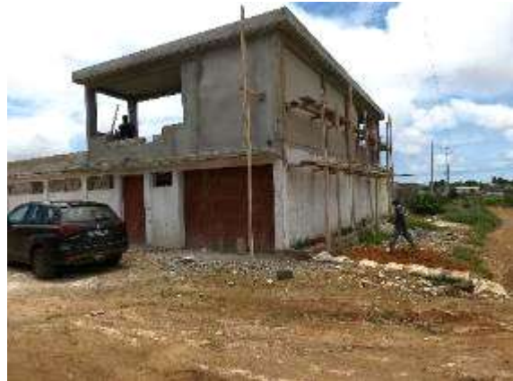
Maison d'habitation en construction à Songon-Dagbé qui tombe dans l'emprise, près du pylône 62 (photo ERM prise le 17 septembre 2023)
