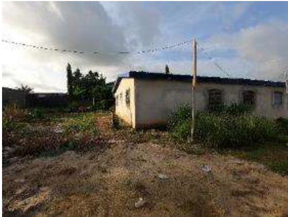
Maison d'habitation à Songon-Dagbé tombant dans l'emprise, près du pylône 62 (photo ERM prise le 25 mai 2023)
