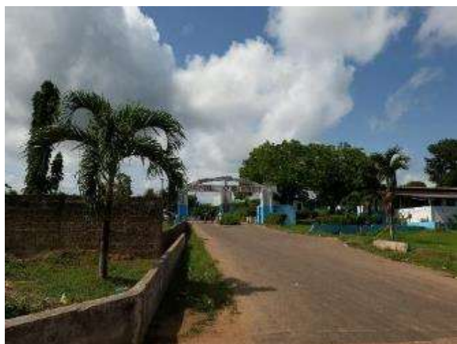
Figure 4-57 Hôpital Méthodiste à Dabou
