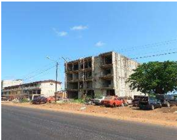
Maison inachevée à Dabou (photo ERM prise le 24 mai 2023)
