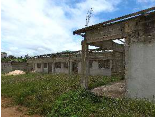
Maison inachevée à Songon-Dagbé (photo ERM prise le 17 septembre 2023)
