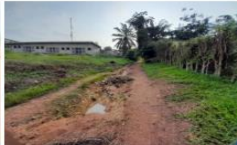
Aperçu d'une voie
