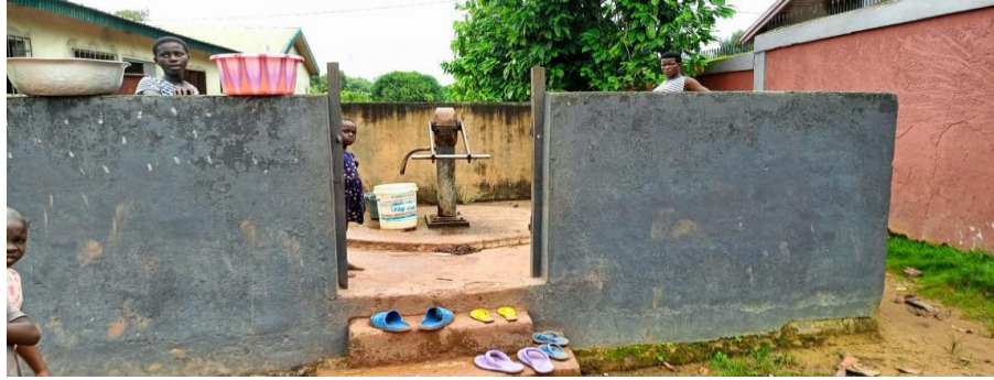
Photo 9 : Pompe Hydraulique du village de Koukourandoumi
