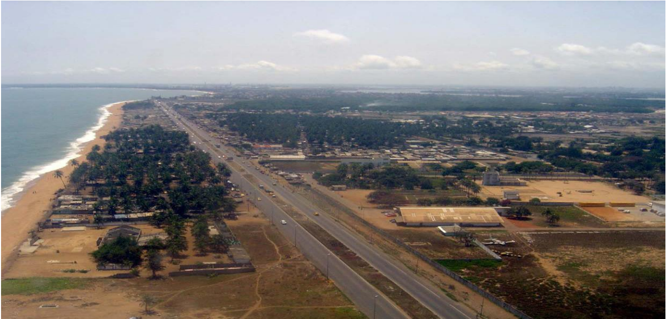
Photo 2 : Vue de la commune balnéaire de Port Bouët
