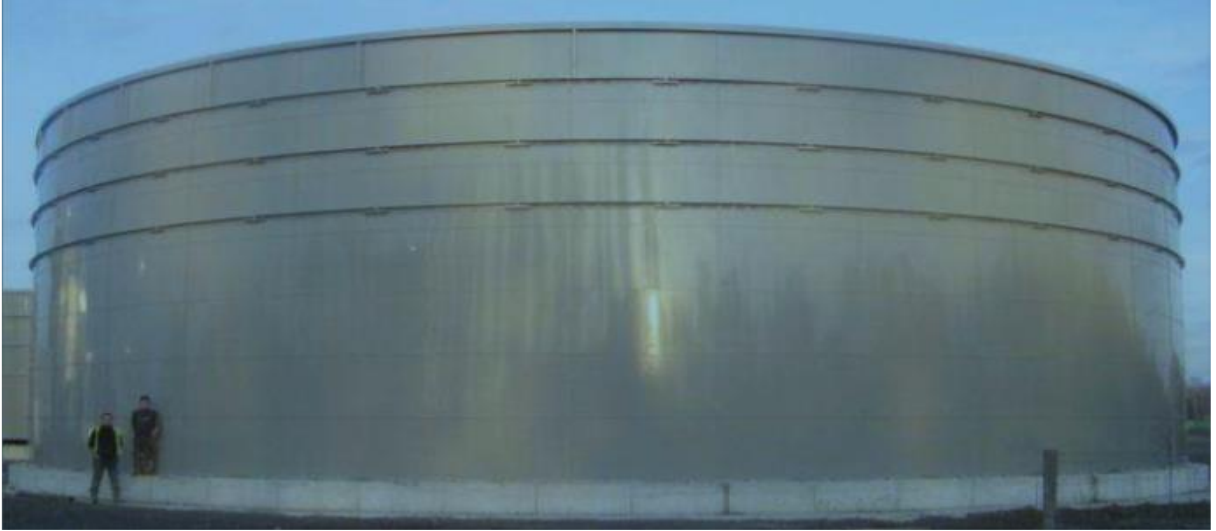
Figure 12: Réservoir d'eau anti- incendie de KAMA-CI
