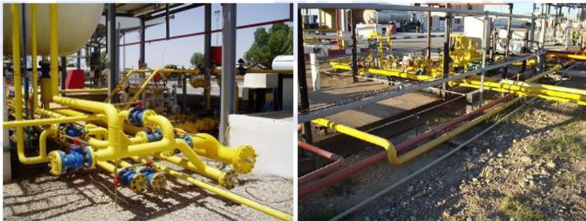
Figure 5: Réseau de tuyauterie GPL
