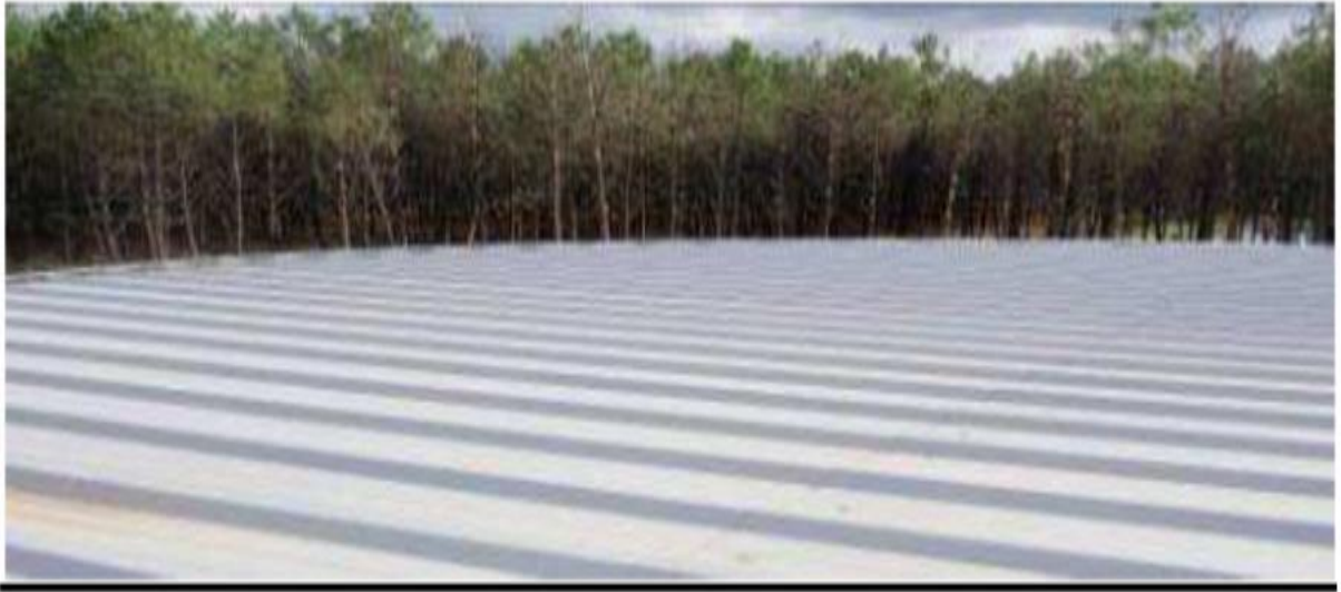
Figure 13: Toiture du réservoir d'eau incendie
