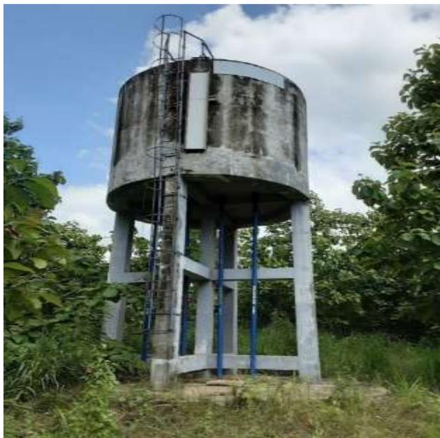
Photo 4 : Le château d'eau, réalisé en 2015 dans le cadre du projet PARTAM, n'a pas été exploité depuis sa construction (mission TOVE).
