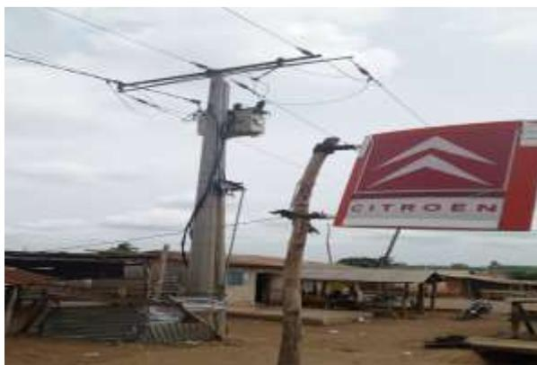
Photo 5 : DHP, un disjoncteur à commande manuelle qui a pris feu et a été remplacé par un TUR 4 (Tableau Urbain Réduit)
