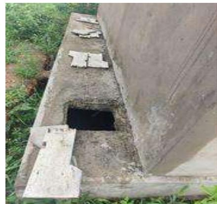
*Photo 8 : fosse septique non couverte de la latrine réalisée dans le cadre du projet de la centrale de la Blitta (Katakpé)*
