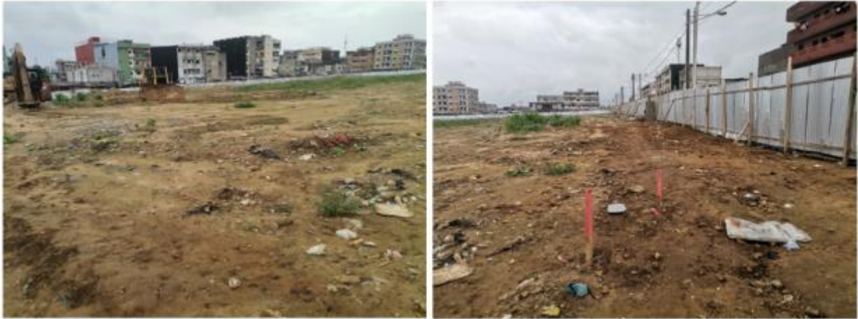
Vues du site du projet (Source : ECA, juin 2024)
