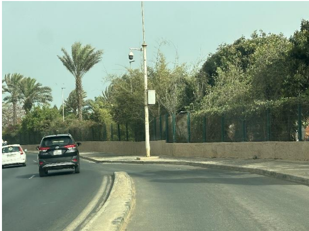
Photo 13 : Caméra de surveillance existante entre Hôtel Terrou Bi et les 2 voies de corniche
