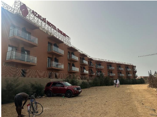
Photo 14 : Emplacement façade Est Hôtel Azalaï
