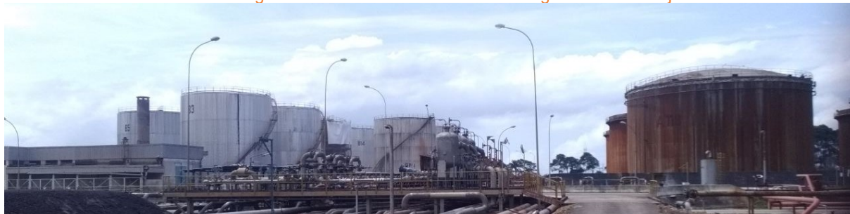
Photo 2 : lignes de basse tension dans le voisinage du site du Projet
