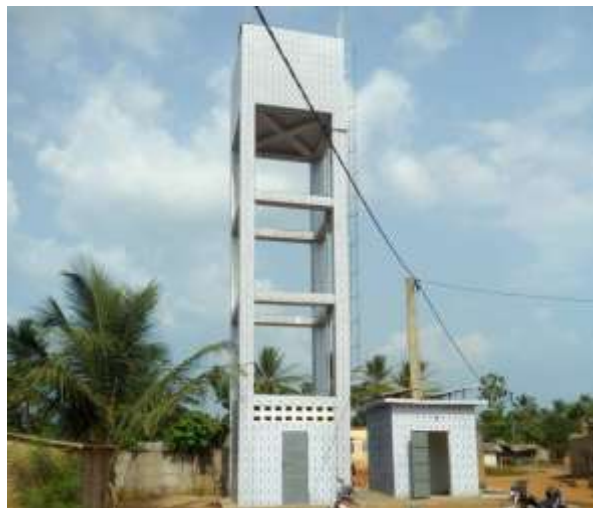
Photo 12. Fontaine publique dans le village Source : Consultant, 2020
