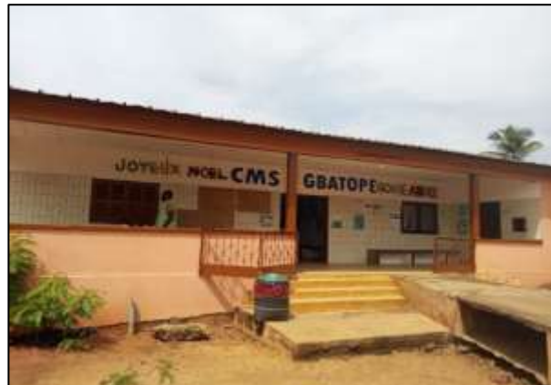
Photo 16. Vue du Centre de Soins Périphérique de Gbatopé, Consultant, 2026
