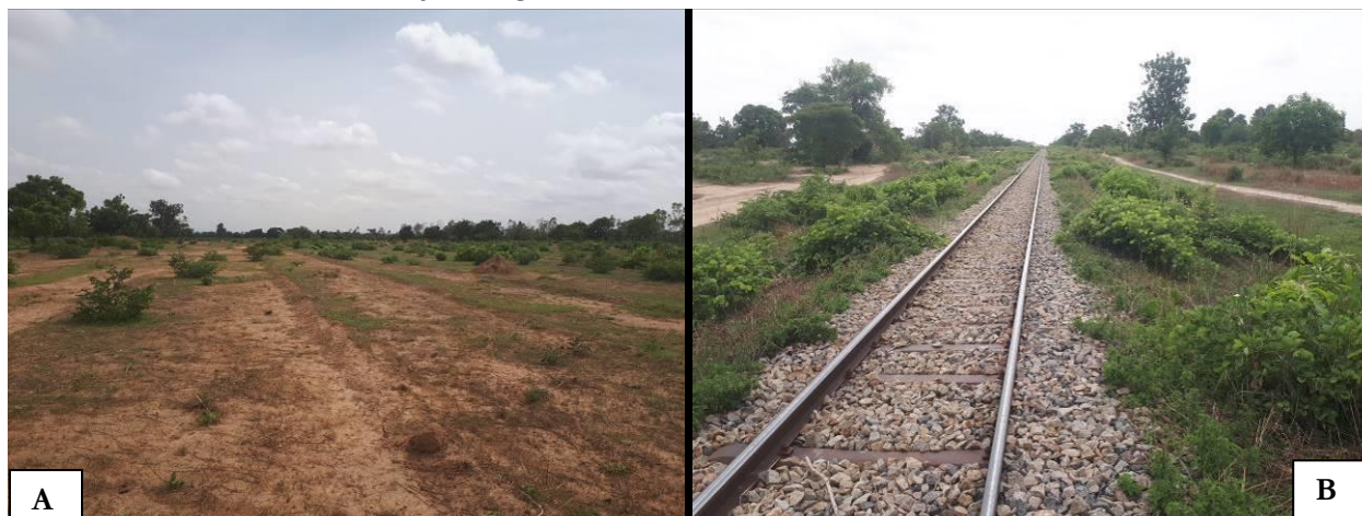
Figure 3 : Vues partielles de la voie de contournement Nord de la ville de Ouagadougou traversant le site du PSMO (A) et du chemin de fer longeant le site du PSMO (A) et du chemin de fer longeant le site du PSMO
