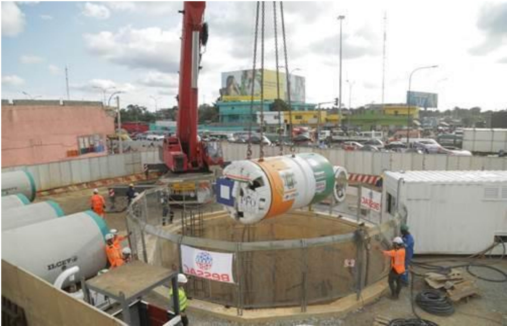
Figure 14 : Puits de sortie
