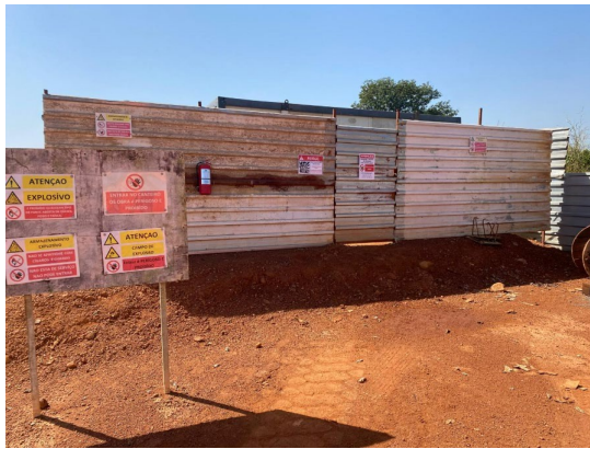
Figure 3-6 Zone de stockage des explosifs (Sustain Africa, 2025)
