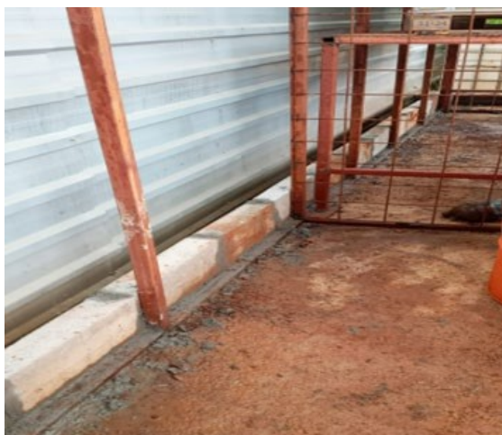
Figure 3-14 Zone de stockage des déchets dangereux – Réparée Confinement
