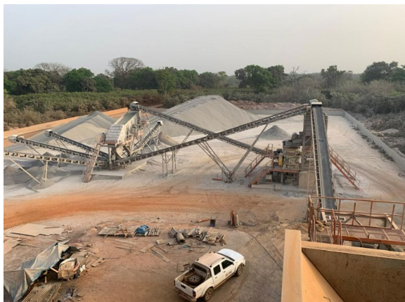
Figure 3-9 Vue de l'installation de concassage et de criblage de la carrière (Sustain Africa, 2025)
